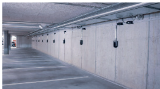
Ladestasjon med strømforsyningsboks og mateboks
