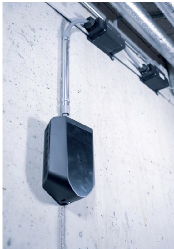
Ladestasjon med strømforsyningsboks og mateboks
